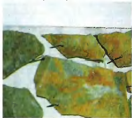
4. Сразу удаляют излишки состава и чистят поверхность.
