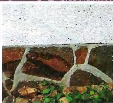
1. К стене из газобетона плитку крепят 2—3 гвоздями.
