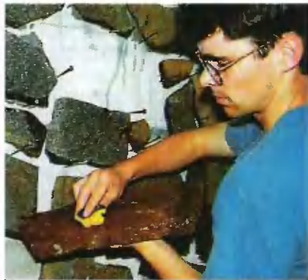
2. Тщательно очищают обе поверхности — и плитки, и стены.
